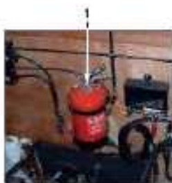
1 - Feste Löschanlage in der Motorbilge. (Zugang in den Motorbilgen)
