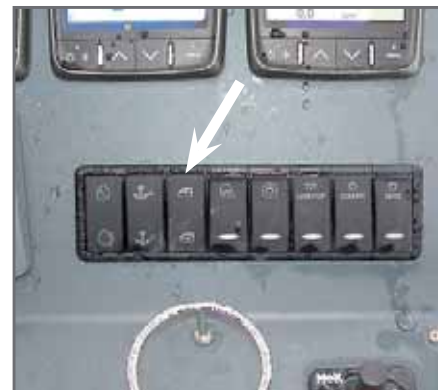
INTERRUPTOR SISTEMA CIERRE DE ACCESO FLY (EN CONSOLA DE FLY)
