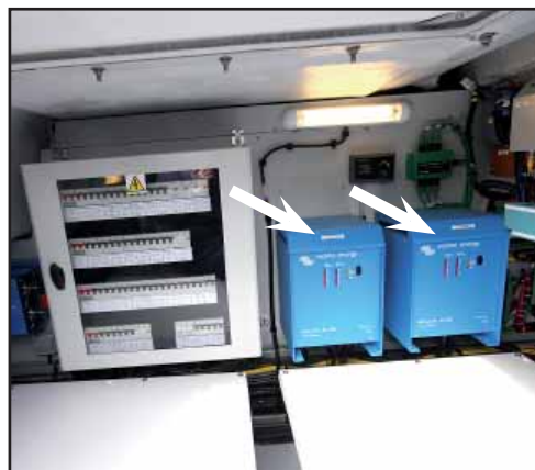
CARGADORES DE BATERÍA 220 V / 24 V
