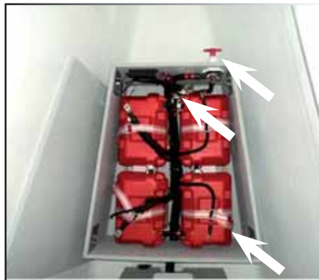
1 - BATTERIES + FUSIBLE + COUPE-CIRCUIT
