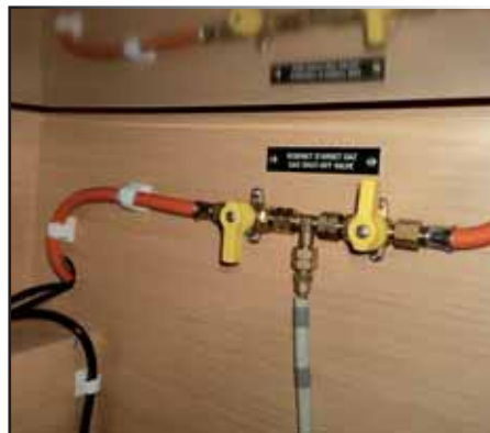
3 - VANNES DE GAZ PLAQUES DE CUISSON ET FOUR
