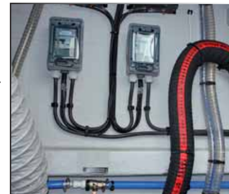
13 - SCHUTZSCHALTER FÜR LANDANSCHLÜSSE
