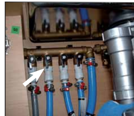
5 - WASSEREINLAUFVENTIL FÜR DIE GESCHIRRSPÜLMASCHINE
