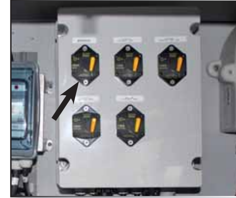
3 - ANKERSPILL- ÜBERLASTSCHALTER
