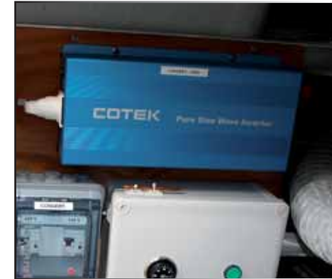
1 - STANDARDSPANNUNGSWANDLER
