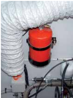
1- Sistema fijo de extintor de compartimento motor (acceso por los compartimentos motor)
